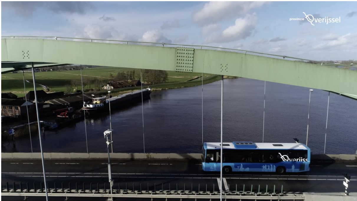
Figuur 3: Via een Innovatiepartnerschap hebben Movares, GeoZICHT en Sobolt met provincie Overijssel een nieuwe methode ontwikkeld voor inspectie van kunstwerken zoals de Zwarte Waterbrug bij Hasselt
