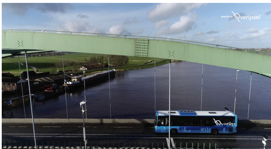
Via een Innovatiepartnerschap hebben Movares, GeoZICHT en Sobolt met provincie Overijssel een nieuwe methode ontwikkeld voor inspectie van kunstwerken zoals de Zwartewaterbrug bij Hasselt
